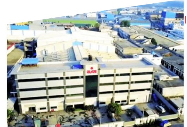
Fan Manufacturing Unit
