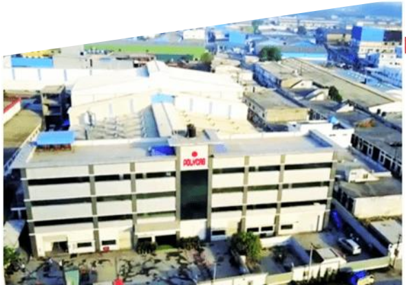
Fan Manufacturing Unit
